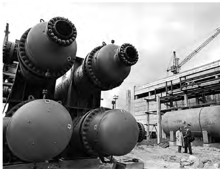
● Строительство установки ЛЧ-35-11/1000
