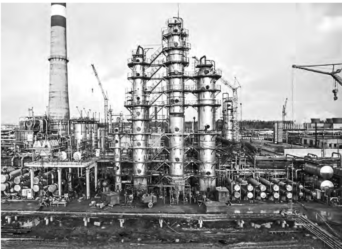
● Строящаяся установка «Парекс-1»
