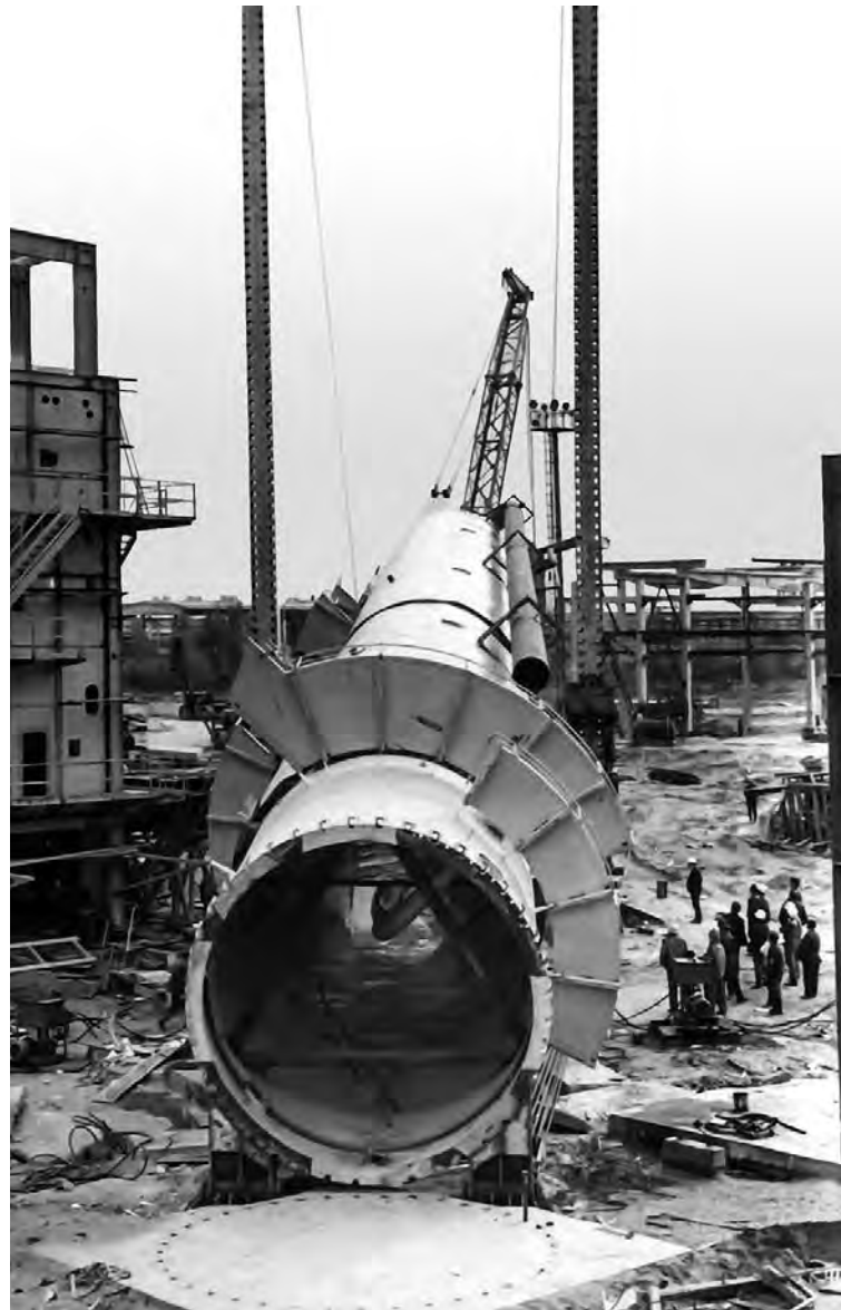
● Строительство ГФУ. Новый метод подъема тяжеловесных колонн на Киришском НПЗ
