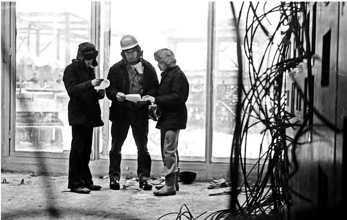
● В будущей операторной ГФУ, в центре – А.А.Канюков
