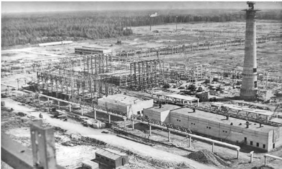
● Строительство установки по производству орто- и параксилолов. 1975 год
