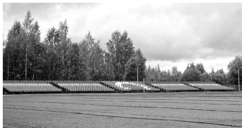
В Тосно полным ходом идёт ремонт социальных и спортивных объектов
