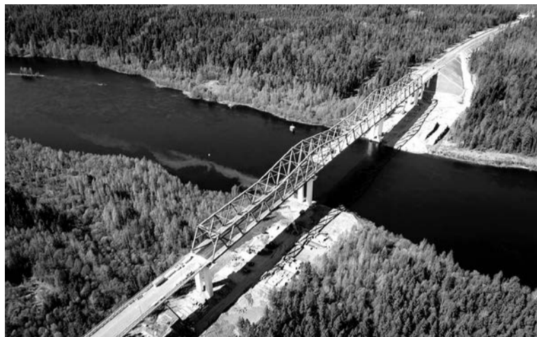
Строительство моста через реку Свирь стало историческим событием
