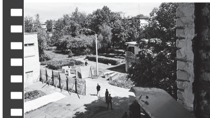
• В год 55-летия Киришская школа №3 вновь стала стройплощадкой. Здесь полным ходом идут работы по программе капитального ремонта «Модернизация школьных систем образования» в рамках государственной программы «Развитие образования»
