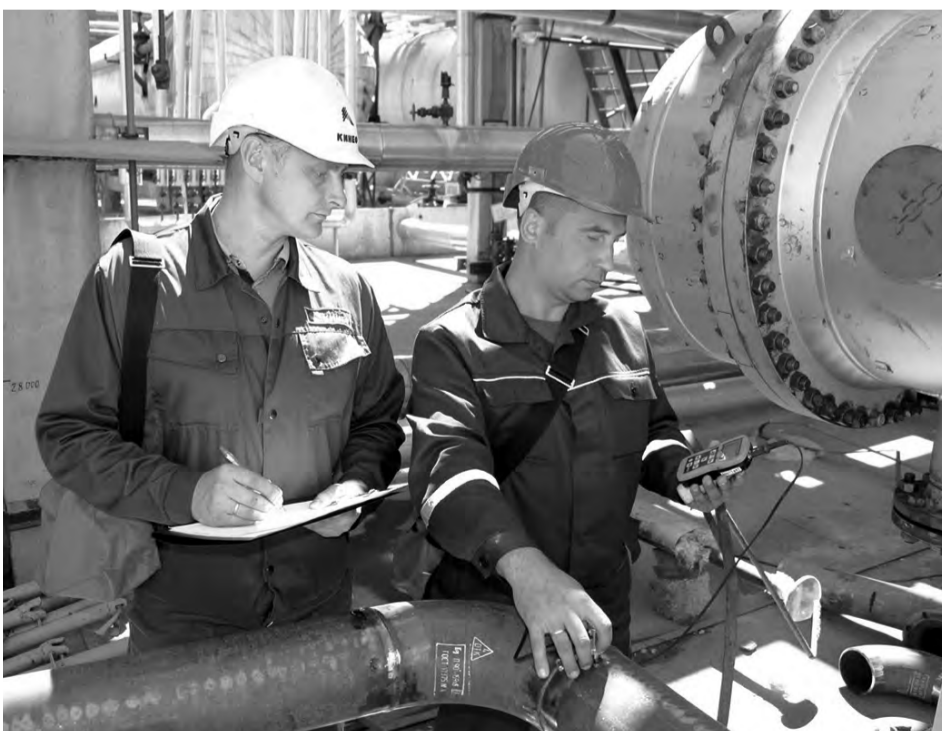
Инженер С.В.Антошков и дефектоскопист по магнитному и ультразвуковому контролю С.П.Зазуляк выполняют измерение толщины стенки технологического трубопровода ультразвуковым толщиномером
