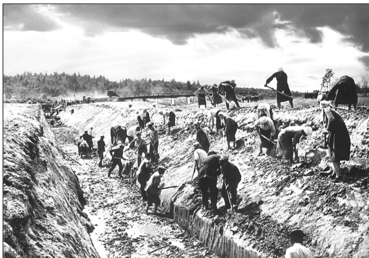
• Жители Волхова на строительстве оборонных сооружений.
