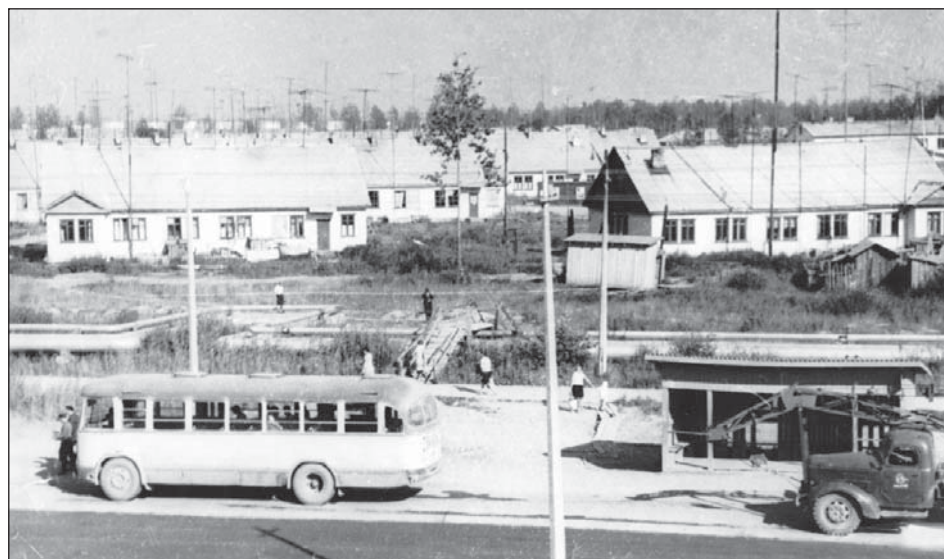
• Бывший посёлок Лесной. Здесь жили рабочие стройтреста. 1960-е годы. ФОТО ИЗ АРХИВА РЕДАКЦИИ «КФ».
