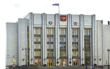
Здание правительства Ленинградской области. Санкт-Петербург, Суворовский проспект, 67.
