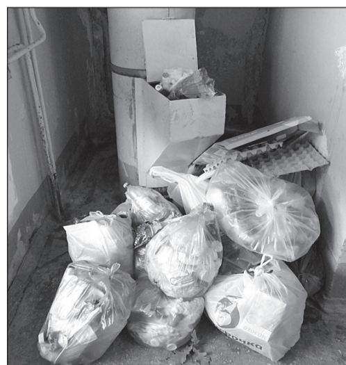
Вот так практически каждый день выглядит мусоропровод между первым и вторым этажами в доме №14 на улице Декабристов Бестужевых. Жаль, что фото не передает «аромат».
