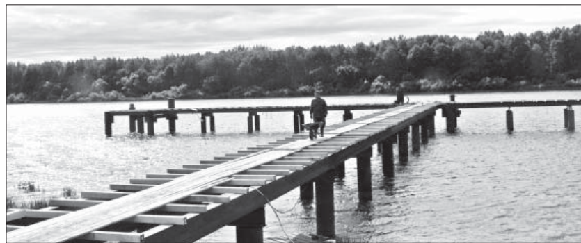
КИРИШИ. Строится причал для туристских судов.
