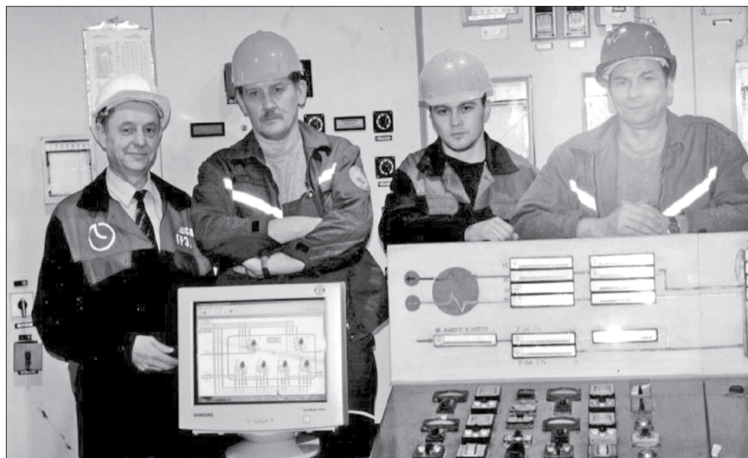
В помещении центрального теплового щита управления КТЦ дежурит смена в составе: (слева направо) начальник смены цеха ТАИ В.И.Мурашко, машинист КТЦ-1 В.Н.Кузнецов, машинисты-обходчики В.Е.Шимов и В.М.Бабаев. ФОТО: В.КУЧЕРЕНКО
